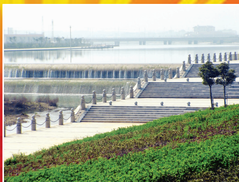
白沙溪堤防工程
