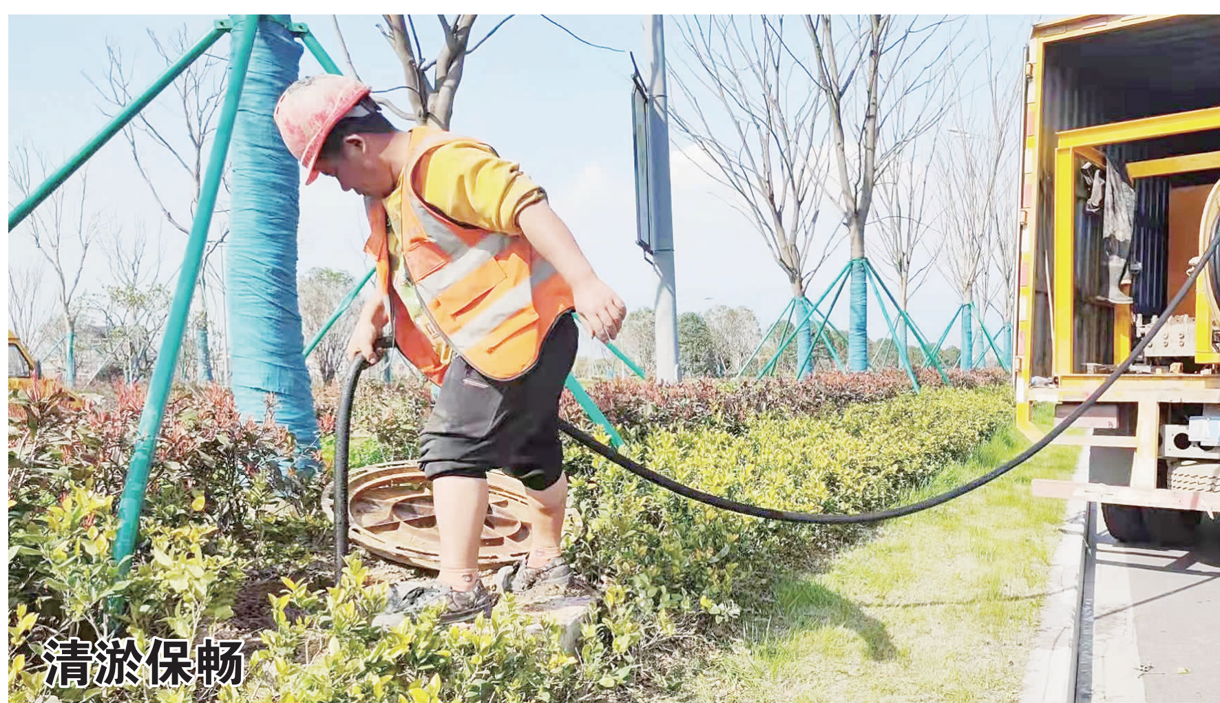
近日,记者在婺城区西二环路看到,施工人员正趁着晴好天气,在对道路污水管道进行清淤工作,维护市政设施。施工人员将鼓风机放入检查井并进行换气通风,随后使用管道内窥镜对管道内部情况进行勘察作业。“管道的疏通、维护很重要,一旦清理不及时或不到位,就会影响整个城市的排水、排污。”施工人员告诉记者。 见习记者 张艺 摄
